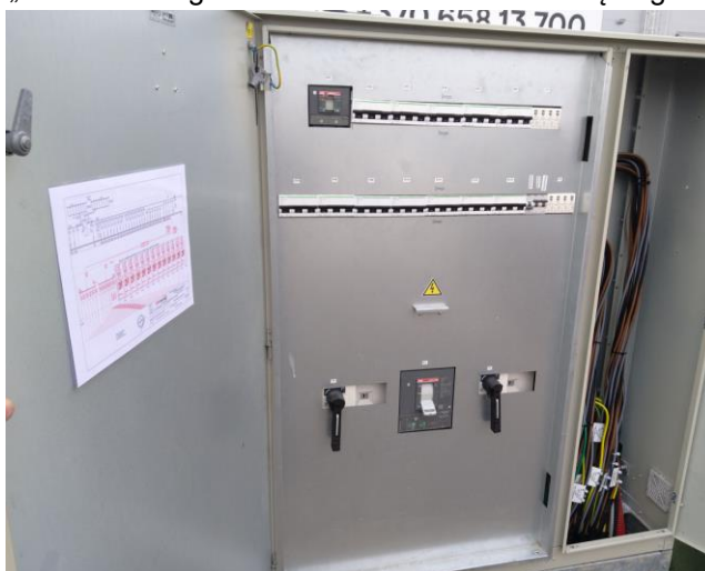
5.16.12 p. Įrengtas paskirstymo skydas su schema, įrenginių pavadinimais
