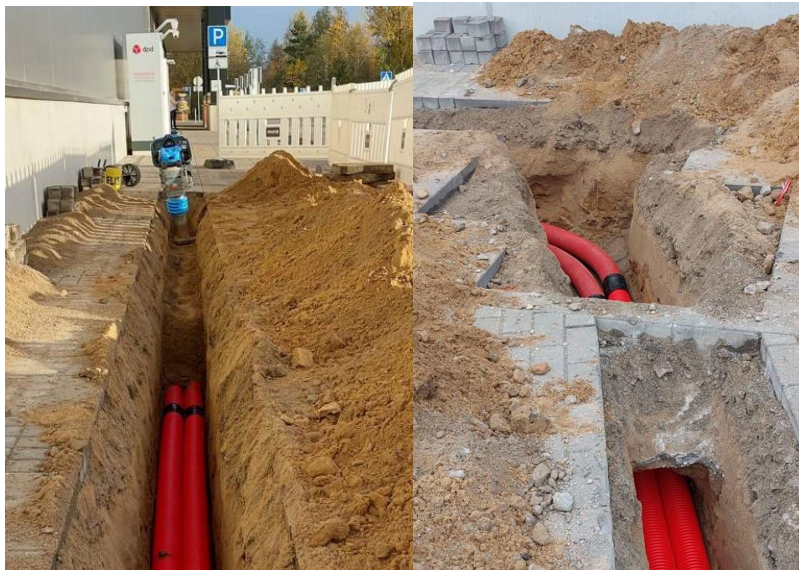
5.15.34 p. 3. Įrengti apsauginiai vamzdžiai išardžius trinkelį dangą
