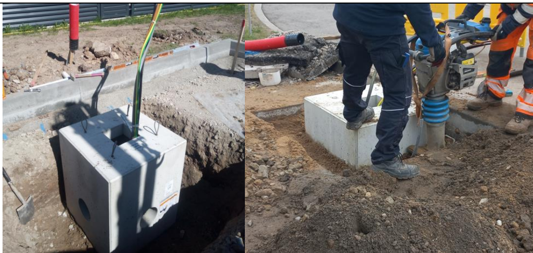
5.11.8 p. 1. Įrengtas pamatas parengtoje duobėje ir dangų aplink pamatą sutankinimas
