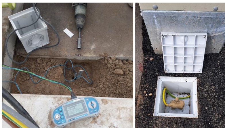
5.18.6 p. Išmatuota įžeminimo varža ir įrengtas įžeminimo kontūras
