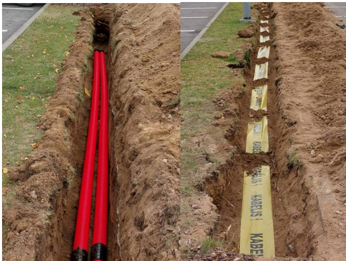
5.15.34 p. 2. Įrengti apsauginiai vamzdžiai sujungti spec. movomis ir paklota signalinė juosta
